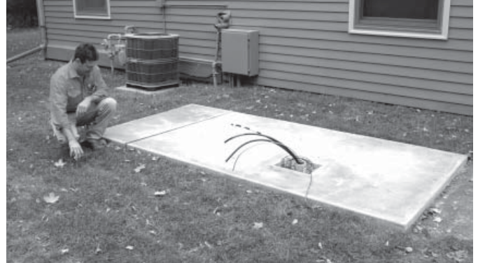
Figure 1.2 — Position Conduit
