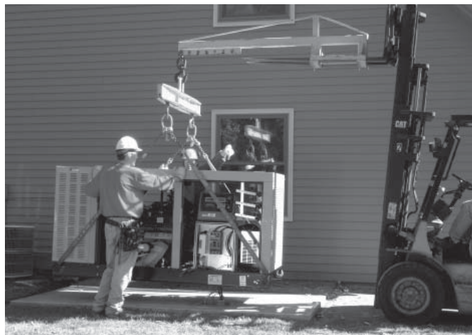
Рисунок 1.4. Подъем генератора
