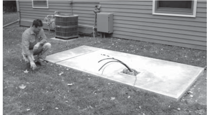
Figura 1.2 - Posición del conducto
