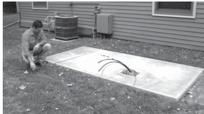
Рисунок 1.2. Расположение кабелепровода
