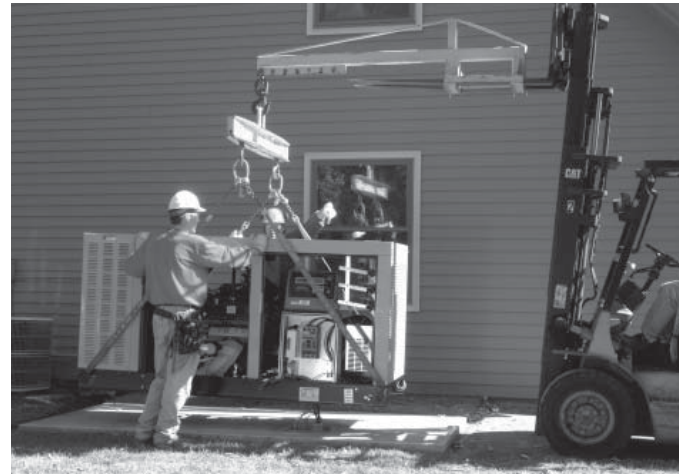
Figura 1.4 - Izado del generador
