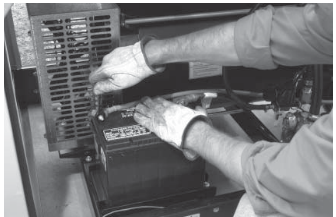
Figura 1.15 - Compruebe las conexiones de terminales
